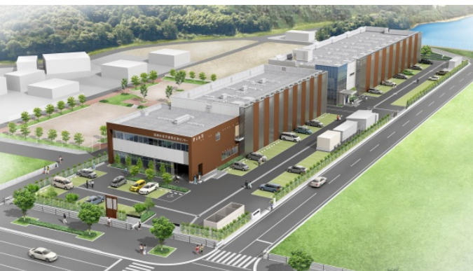
既存棟（現センター：手前）と新棟（第二センター：奥）
